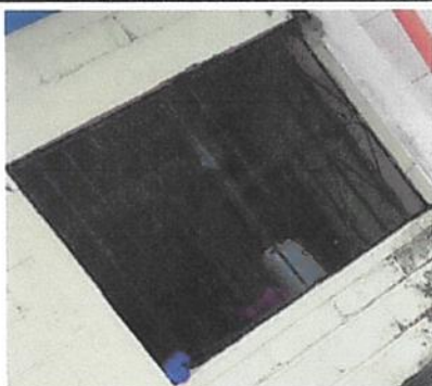
Foto 3: Colocación de Ventanas tipo Pvc con sedazo de 1.71 mts X 1.27 mts
