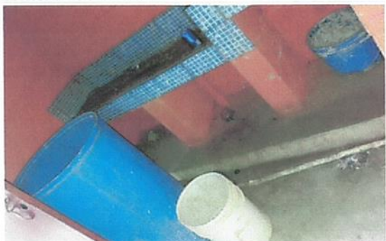
Foto 7: Mejoramiento de Sistema de drenaje de baños existentes, Cambio de Tubería hacia fosa existe
