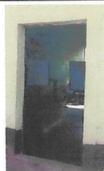
Foto 12: Cambio de Chapa y Pintura en Puerta Principal de Aula
