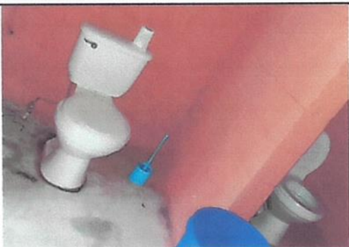
Foto 9: Mantenimiento de 2 baterías de baños, limpieza y accesorios
