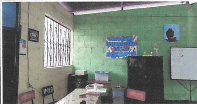
Foto 4: Pintura de Interior y Exterior de Aula Existente
