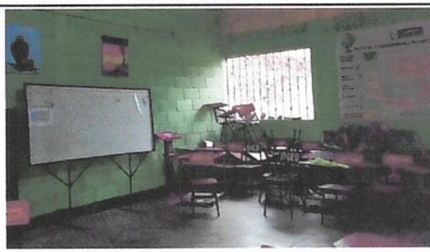
Foto 6: Colocación de Piso ceramico
