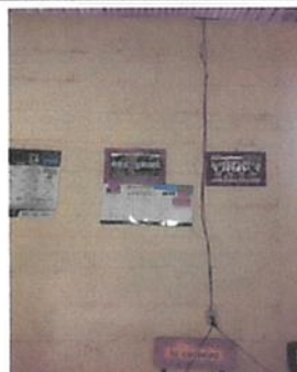
Foto 2: Mejoramiento sistema Electrico, entubar 20 metros lineales de cable No. 10.
