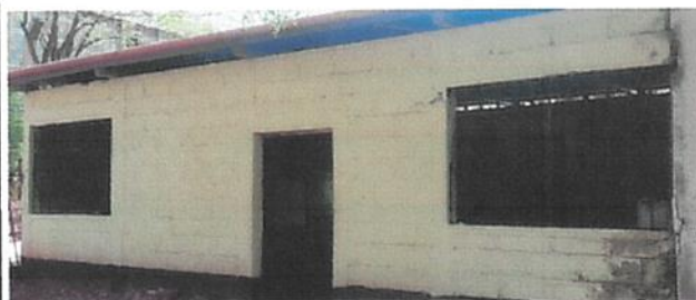
Foto 10: Mantenimiento de balcones de 1.75 mts X 1.30 mts, Limpieza, Refuerzos y Pintura
